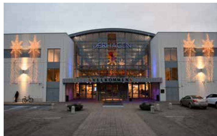
Jærhagen, COOP bruker solenergi til kjølelager og lading av elbil.
