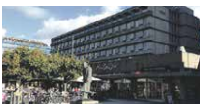
Solli Plass – Oslo Henrik Ibsens gate 90, 3. etg.
