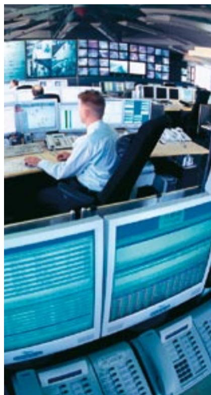
Fra overvåkingssentralen har man full kontroll over alle tekniske installasjoner; sikkerhet, videoovervåking, IT-installasjoner, energistyring, byggautomasjon.
